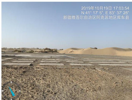
井场恢复情况
