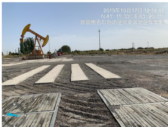
井场恢复情况
