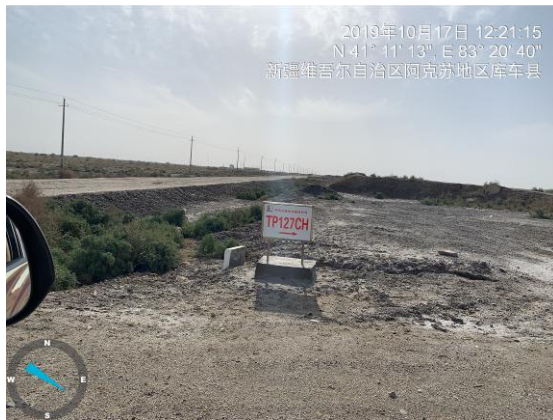
TP127CH 井电力线
