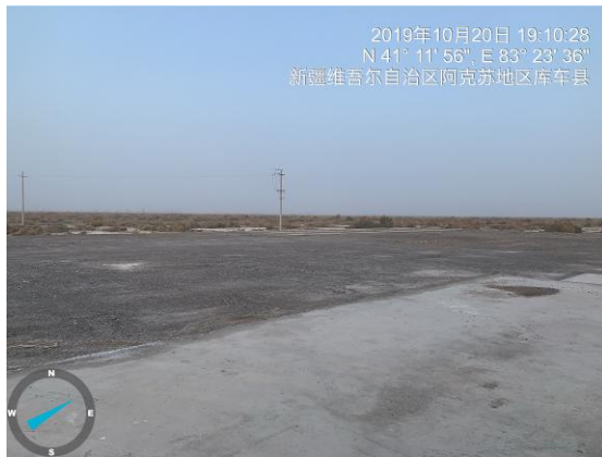
TP177CH 井电力线
