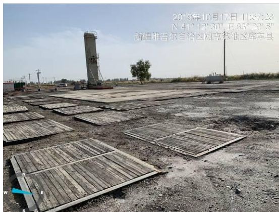
井场恢复情况
