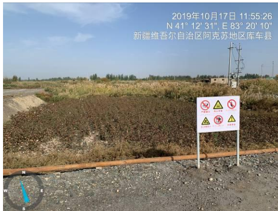
TP180CH 井电力线
