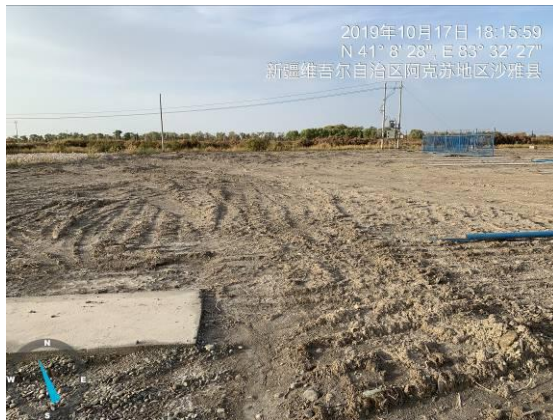
TP199 井电力线
