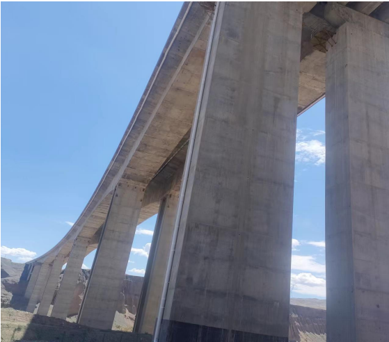
三屯河大桥桥面径流系统
