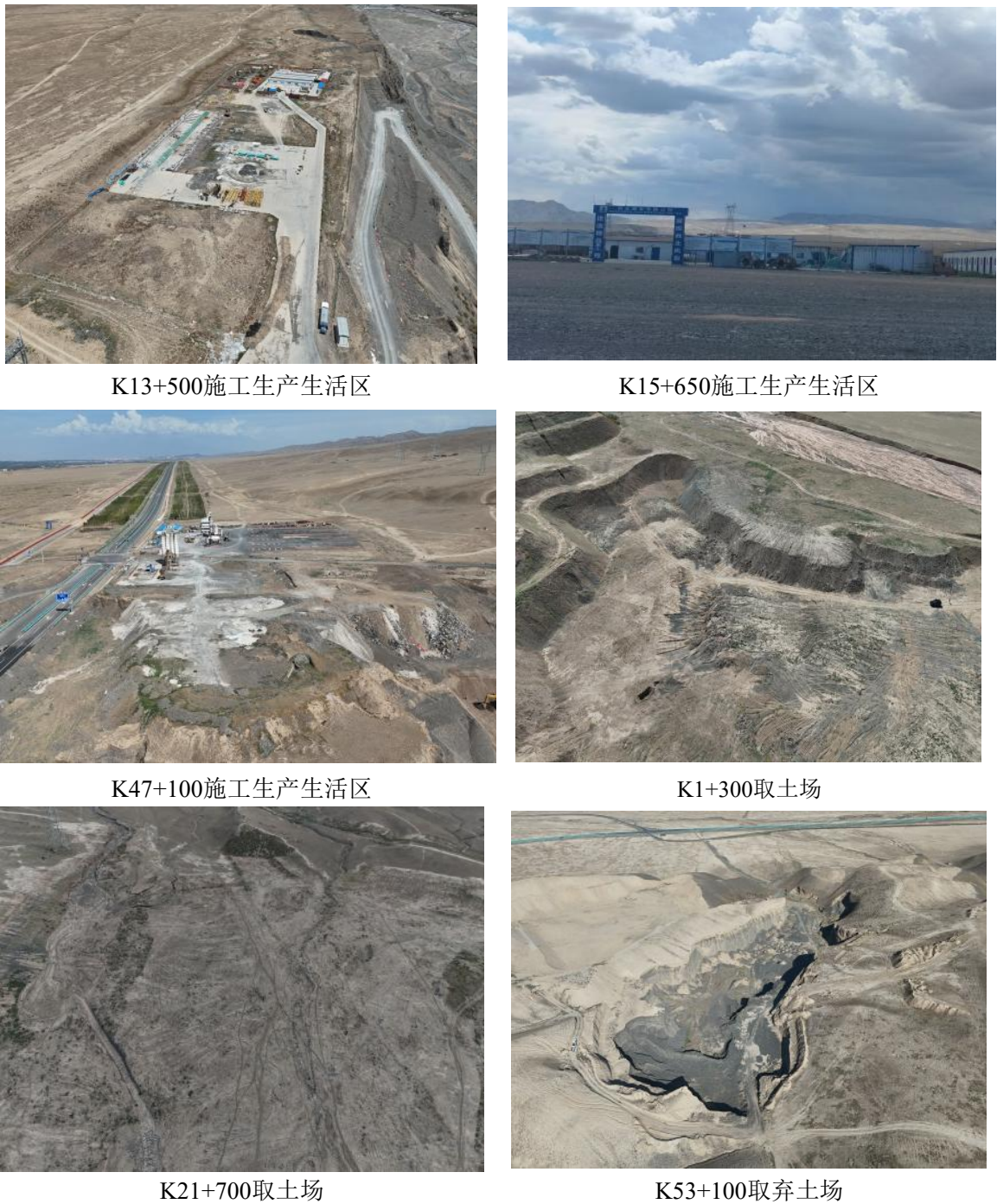
图 3.5-3 临时工程现状情况照片
