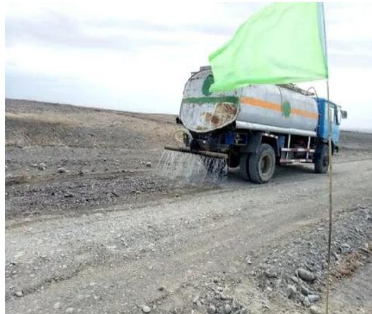
图 11 施工现场洒水降尘
