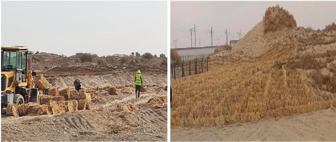
图 16 沙障施工及效果图
