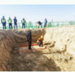
图3 高速公路改扩建施工现场。
