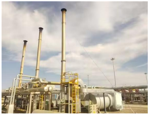
废气排放口标志牌
