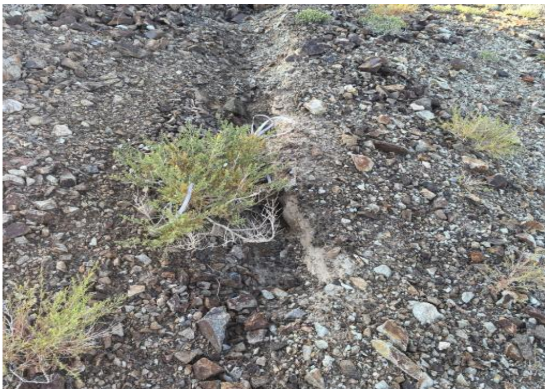
裂缝封堵后自然恢复
