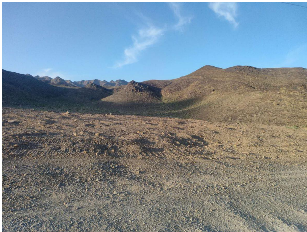
尾矿库下方道路两侧恢复情况
