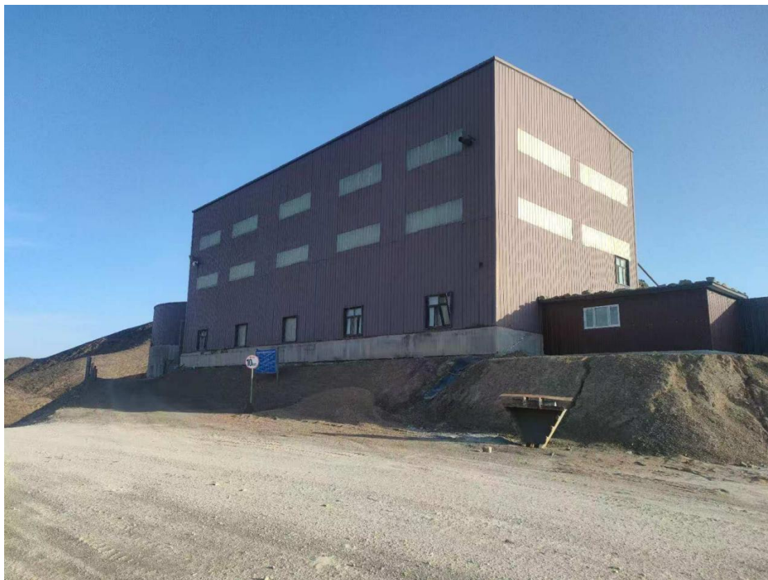
图 3.4-11 尾矿库压滤厂房
