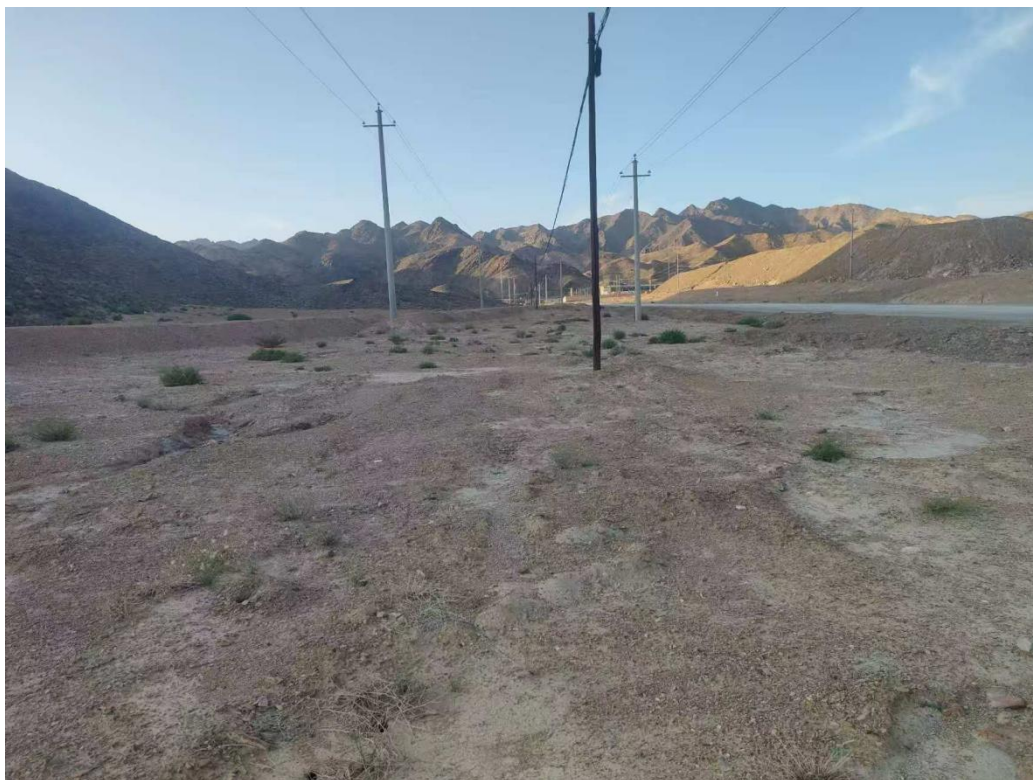
道路两侧恢复情况
