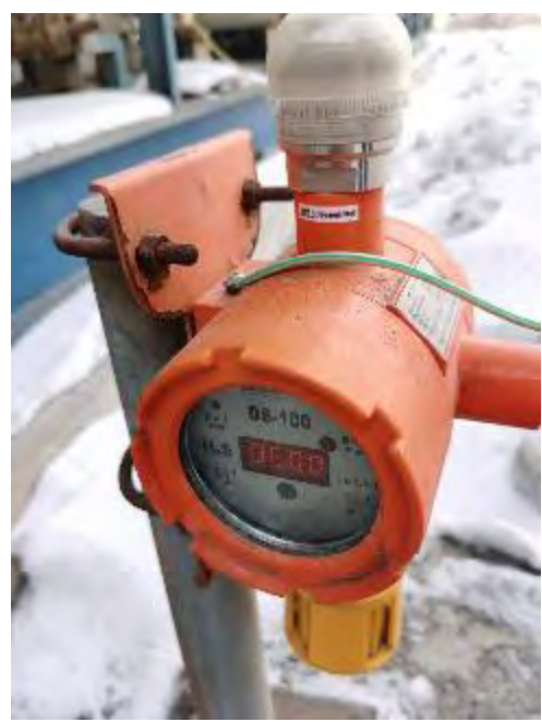
150 万吨/年重油催化裂化装置硫化氢报警器
