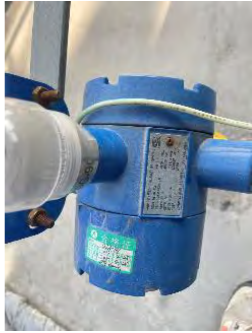
30 万吨/年气分装置可燃气体报警器
