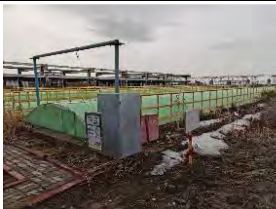
汽车装车 1400 方事故水池
