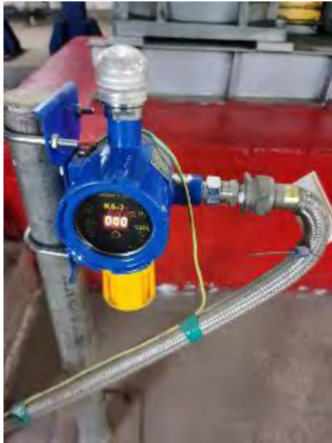
180 万吨/年柴油加氢改质装置可燃气体报警器
