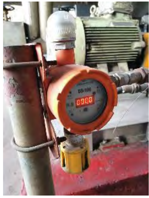
600 万吨/年常减压装置硫化氢报警器
