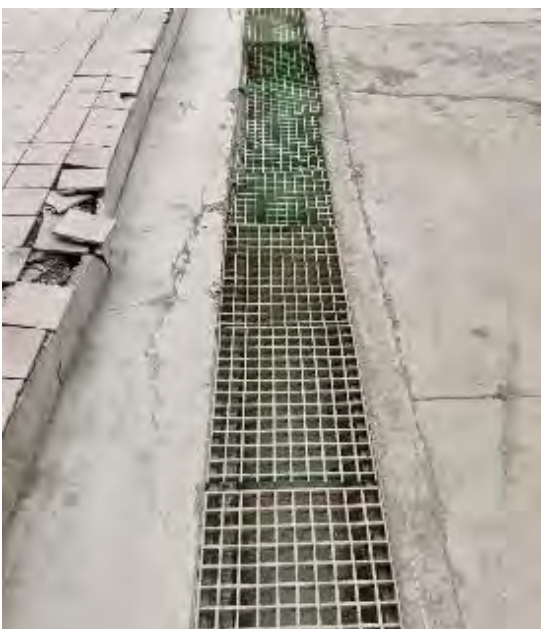
4 吨/年硫磷回收装置雨水明沟
