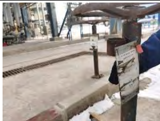
30 万吨/年轻烃分离装置雨污切换阀
