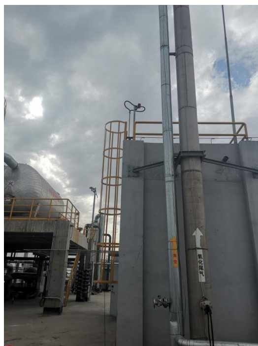
左边为氢化尾气排气筒、右边为氧化尾气排气筒
