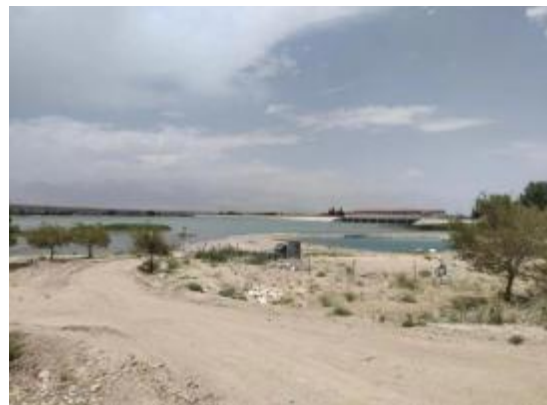
开都河第一分水枢纽
