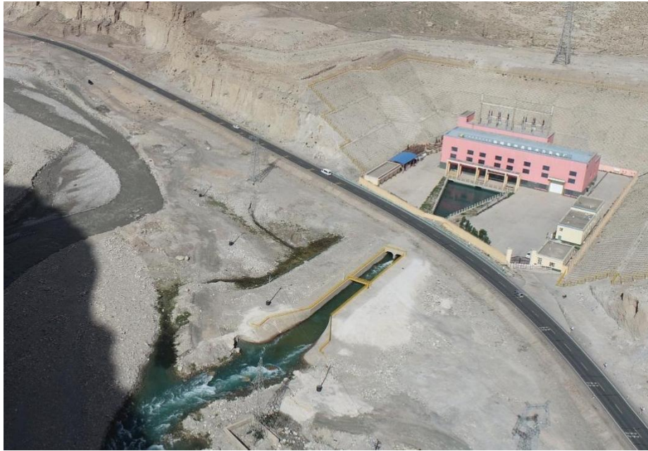
盖孜水电站厂房及尾水渠
