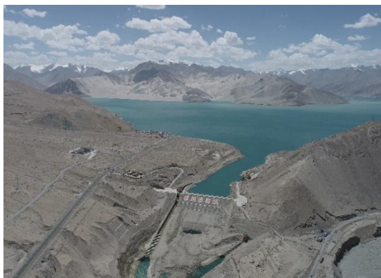
布仑口水库大坝
