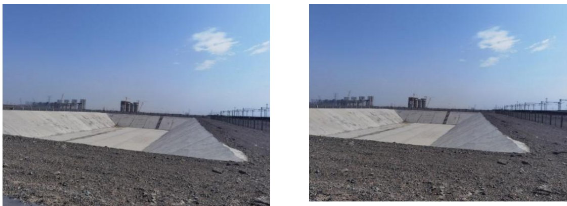
白石湖南站既有蓄水池
