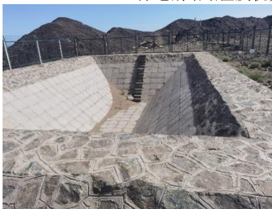
克音沟站既有蓄水池
